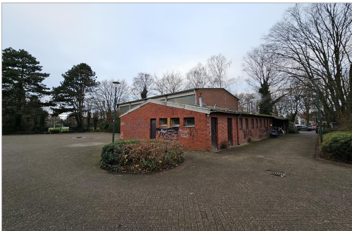
Abb. 8: Sporthalle und versiegelte Platzfläche, Blick von Südwesten (Eigene Aufnahme 17.12.2024)
