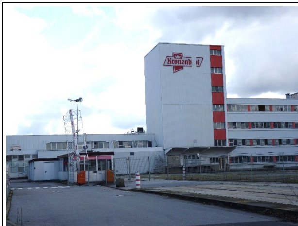
Gebäudestrukturen innerhalb des Änderungsbereiches
