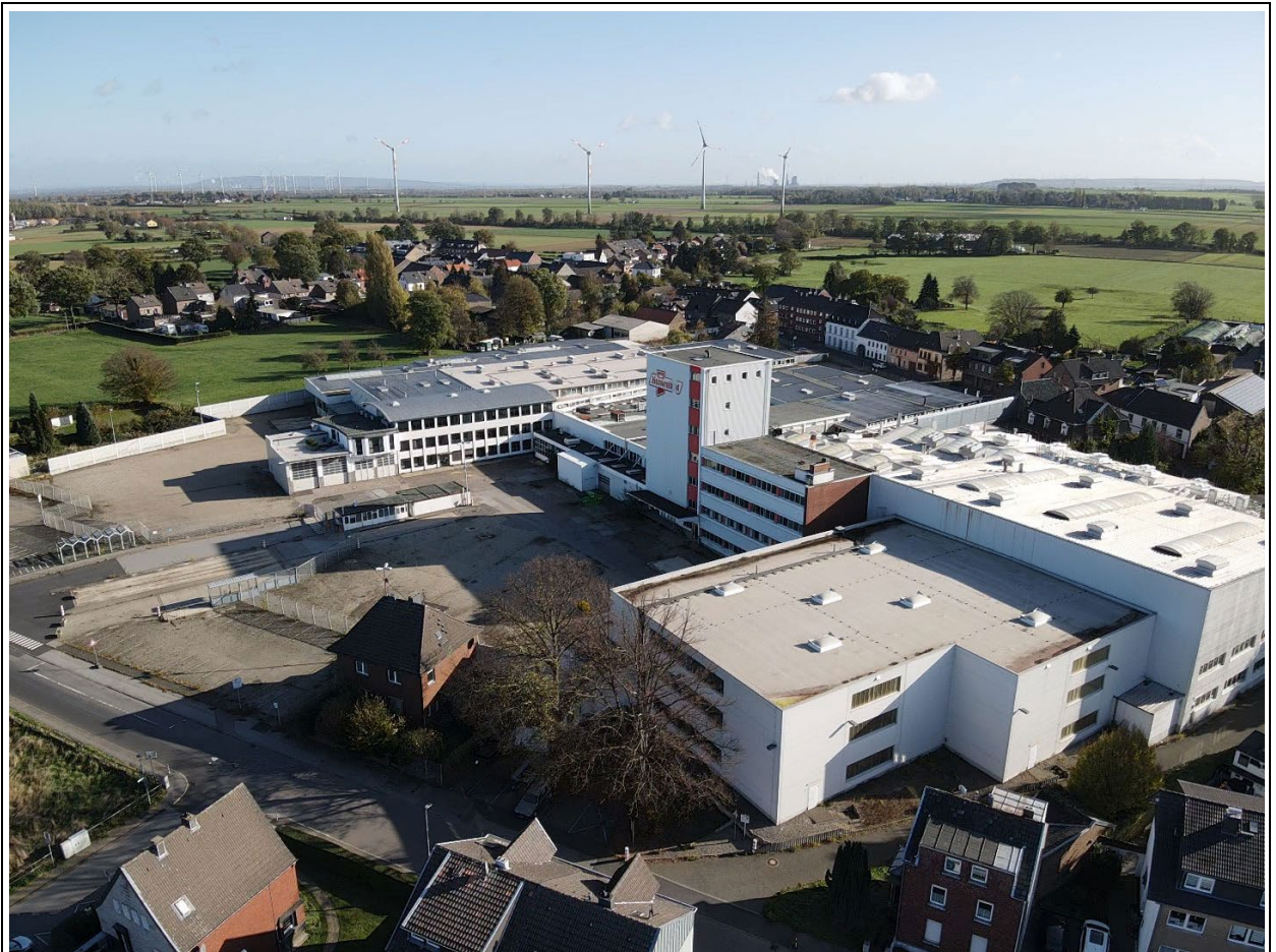
Luftbild 2023 – nach Betriebsaufgabe vor dem Rückbau
