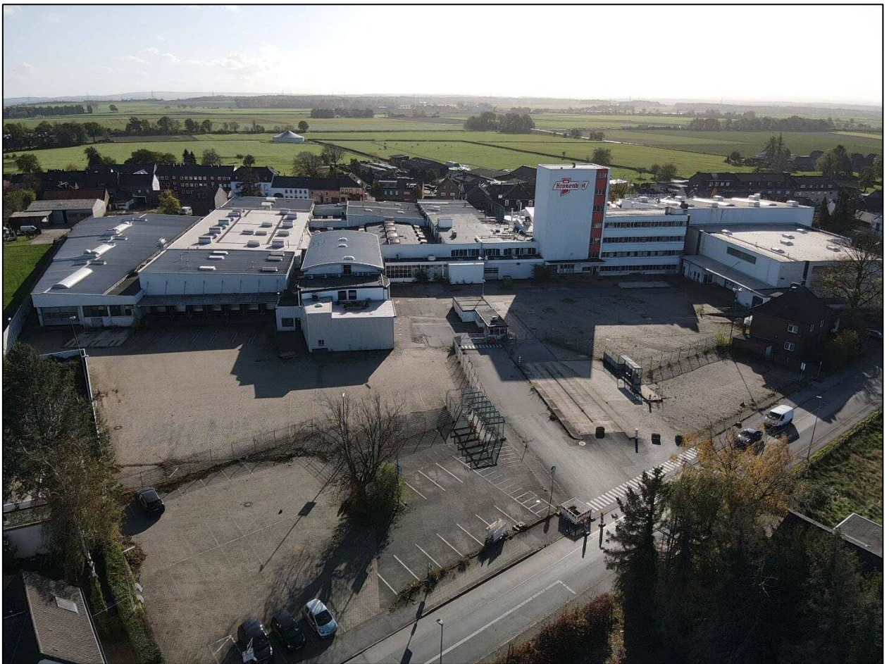
Abbildung 13: Luftbild nach Stilllegung der Großbäckerei Kronenbrot 2021 (Blick nach Osten)
