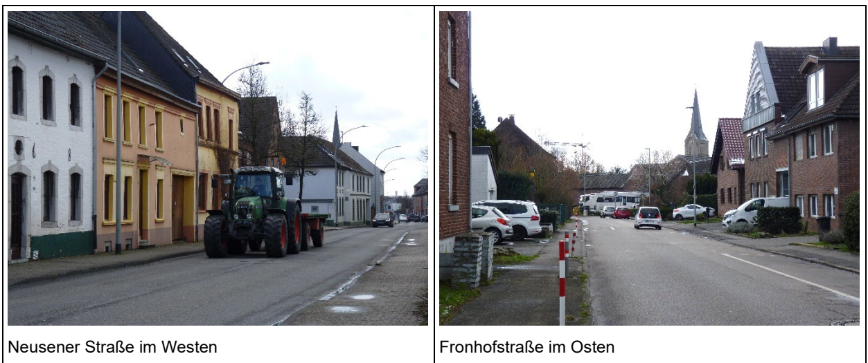
Abbildung 12: Angrenzende Straßenräume Fotos BKR Aachen 2023
