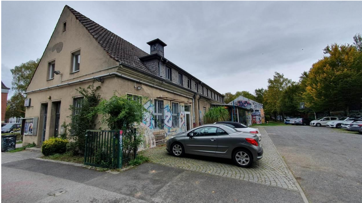
Abb. 5: Gebäude Alter Bahnhof und Parkplatz, Blick von Süden (Foto 09.10.2024).
