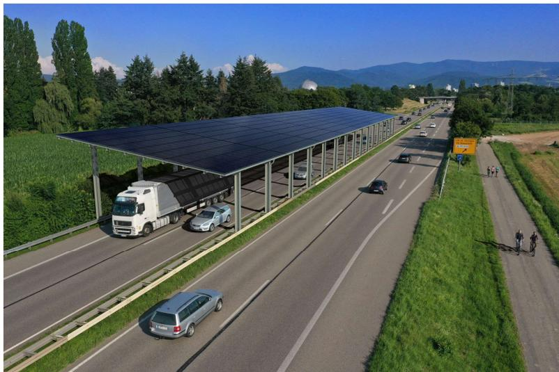
Abbildung 12: Visualisierung einer bifazialen PV-Anlage über einer Autobahn © Fraunhofer ISE
